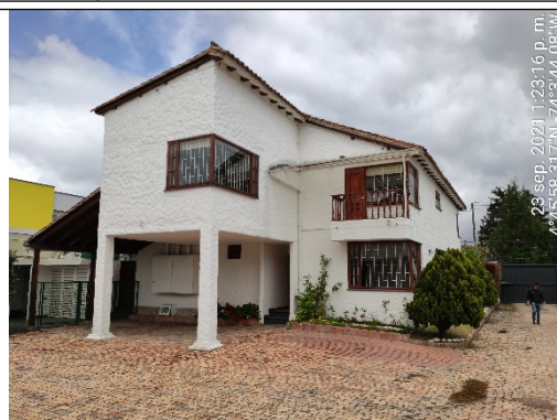
Foto No. 18. Canales y bajantes para evacuación de ALL Conjunto Residencial El Trebol – PH.
