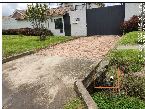
Foto No. 16. Tubería margen izquierdo vallado Av. Kr. 72. – procedencia por determinar.
