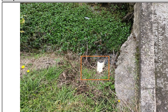
Foto No. 15. Tubería margen izquierdo vallado Av. Kr. 72. – procedencia por determinar.
