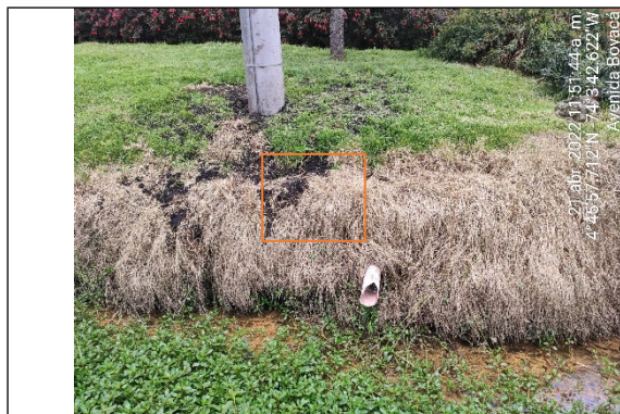
Foto No. 13. Tubería de descarga de “ARDT” margen izquierdo vallado Av. Kr. 72.
