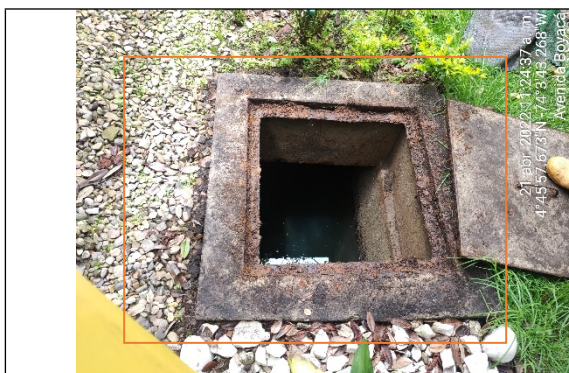
Foto No. 5. Pozo séptico, recamara inicial - Conjunto Residencial El Trebol – PH Av. Kr 72 No. 175 – 65.
