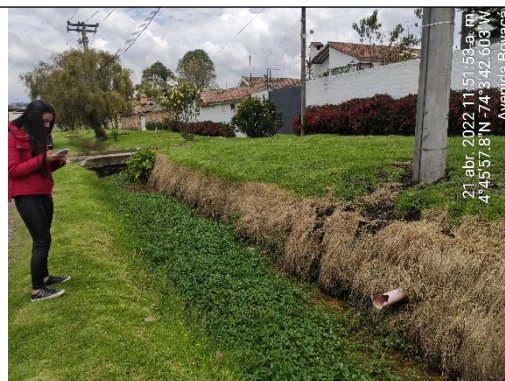
Foto No. 14. Tubería de descarga de “ARDT” margen izquierdo vallado Av. Kr. 72.
